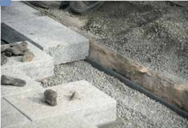
Bei der Läuferzeile wird die außen liegende Schiene hochkant gesetzt und in die Bettung gedrückt
