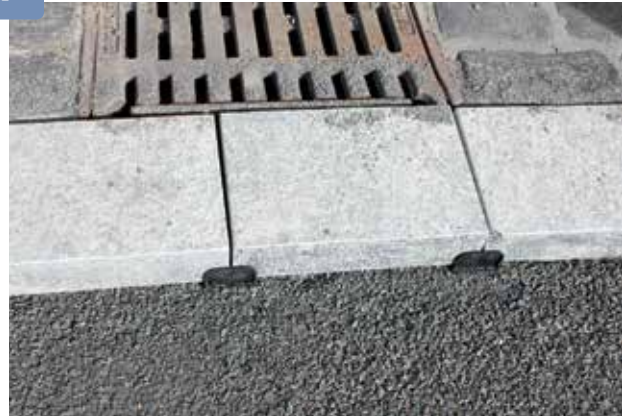
Zwischen den einzelnen Steinplatten der Läuferzeile sitzen die schwarzen T-Abstandshalter
