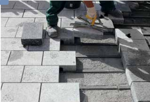
Die Steinplatten werden nun einzeln auf die Schienen gesetzt und richtig positioniert
