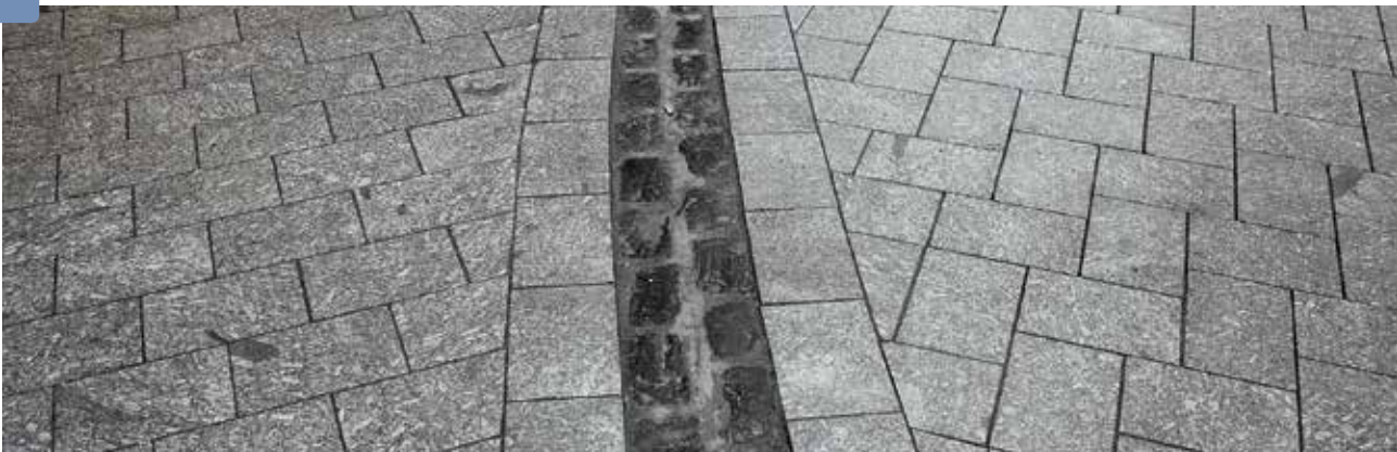
Die hellen Granitplatten aus dem Süden Portugals sind auf dem Marktplatz im Reihenverband verlegt. Die im Ellbogenverband verlegte Straße setzt sich davon ab
