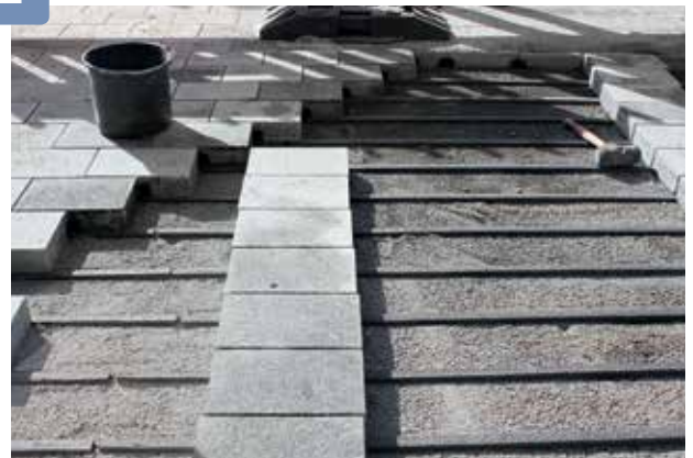
Damit sich die Schienen nicht verschieben, werden zuerst einige Platten in einer Reihe verlegt
