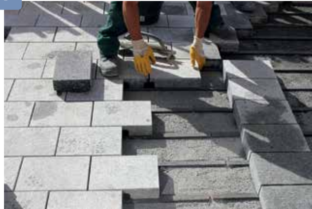
Anschließend wird der Abstandhalter zwischen die Kopffuge gesetzt. So ist der Stein von vier Seiten eingefasst
