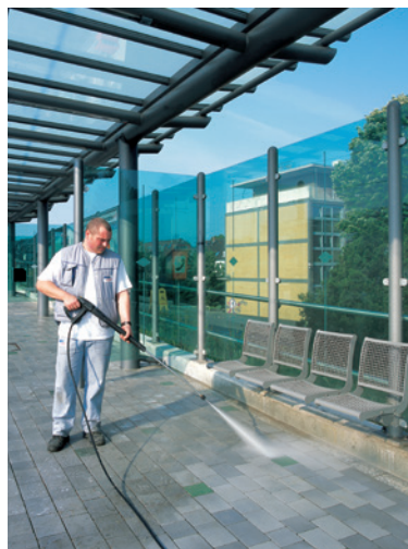
Reiniger aufspritzen. Fläche abspritzen.
