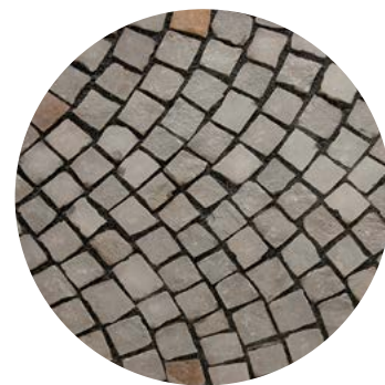
Grauwacke Pflaster mit gespaltener Oberfläche und gespaltene Kanten.
