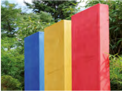
Sichtbeton Grau bauseits gespachtelt und gestrichen
