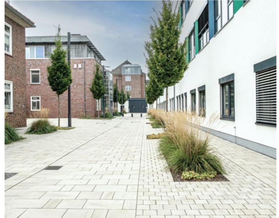
Alle unsere Pflastersteine mit Formaten bis zu  $50 \times 25$  cm sind aufgrund ihres Fugenanteils in der Fläche darauf ausgelegt, die natürliche Versickerung von Regenwasser zu ermöglichen. In Kombination mit einem geeigneten Fugen- und Bettungsmaterial fördern sie die Regenrückhaltung und reduzieren die Belastung der Kanalisation – ohne Kompromisse bei Gestaltung, Stabilität oder Nutzungskomfort.
