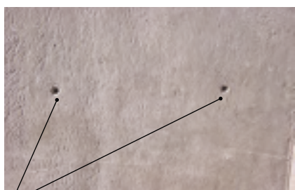
Ankerhülsen als Versetzhilfe
