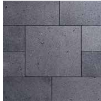
Basaltlava Platten mit diamantgeschliffener Oberfläche. Sehr eben, gut begehbar. Geringer Fugenanteil durch gesägte Kanten.
